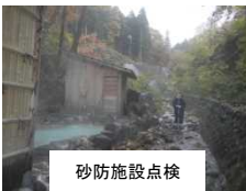
砂防施設点検
