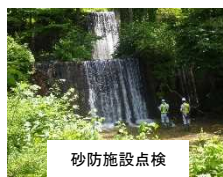
砂防施設点検
